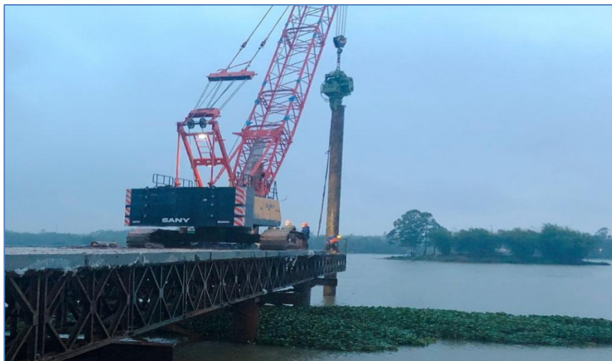
图 2.3.4-3 钢管桩沉桩示意图
