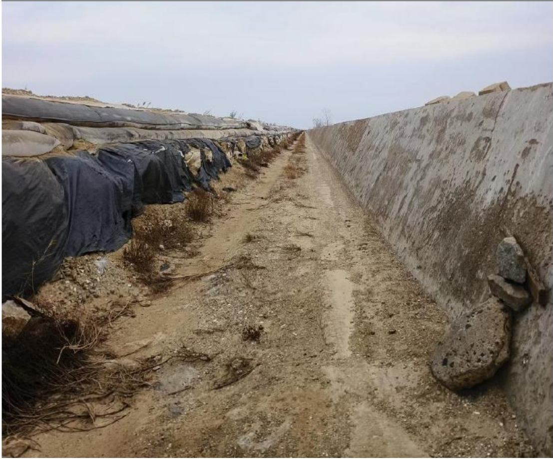
图 2.4-2 围堤堤顶道路及内坡现状
